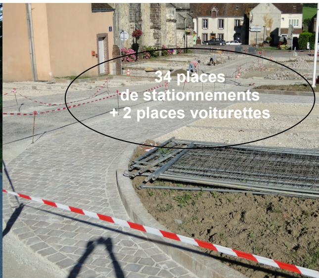
2ème tranche, comprenant place Castle Carry et place Général de Gaulle, côté boucherie. Une étape importante qui a nécessité beaucoup de vigilance pour préserver le passage des pompiers.
