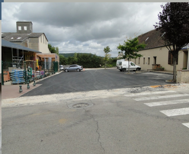
3ème tranche. Aménagement de la ZA du centre.
